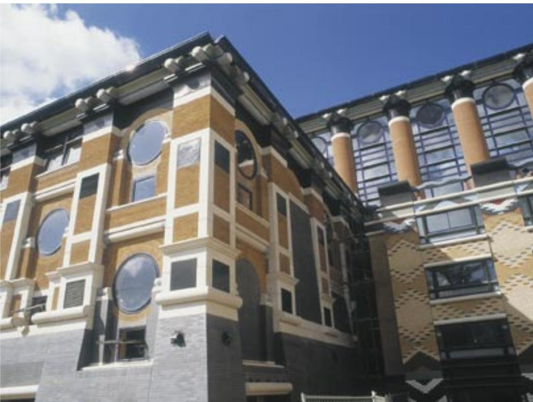
**THE ONLY METAL IS THE CORNICE-GUTTER AND THE OUTSIDE OF THE TIMBER WINDOWS**
